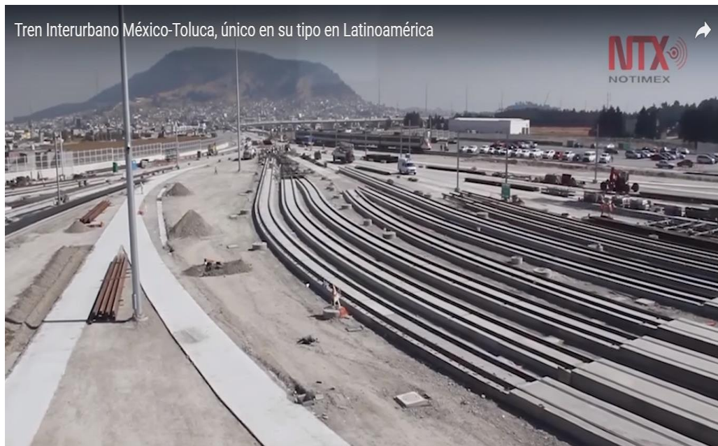
Figura 3.5. Imagen de proceso constructivo de rieles en Buenavista. Fuente: Notimex, 2018.
