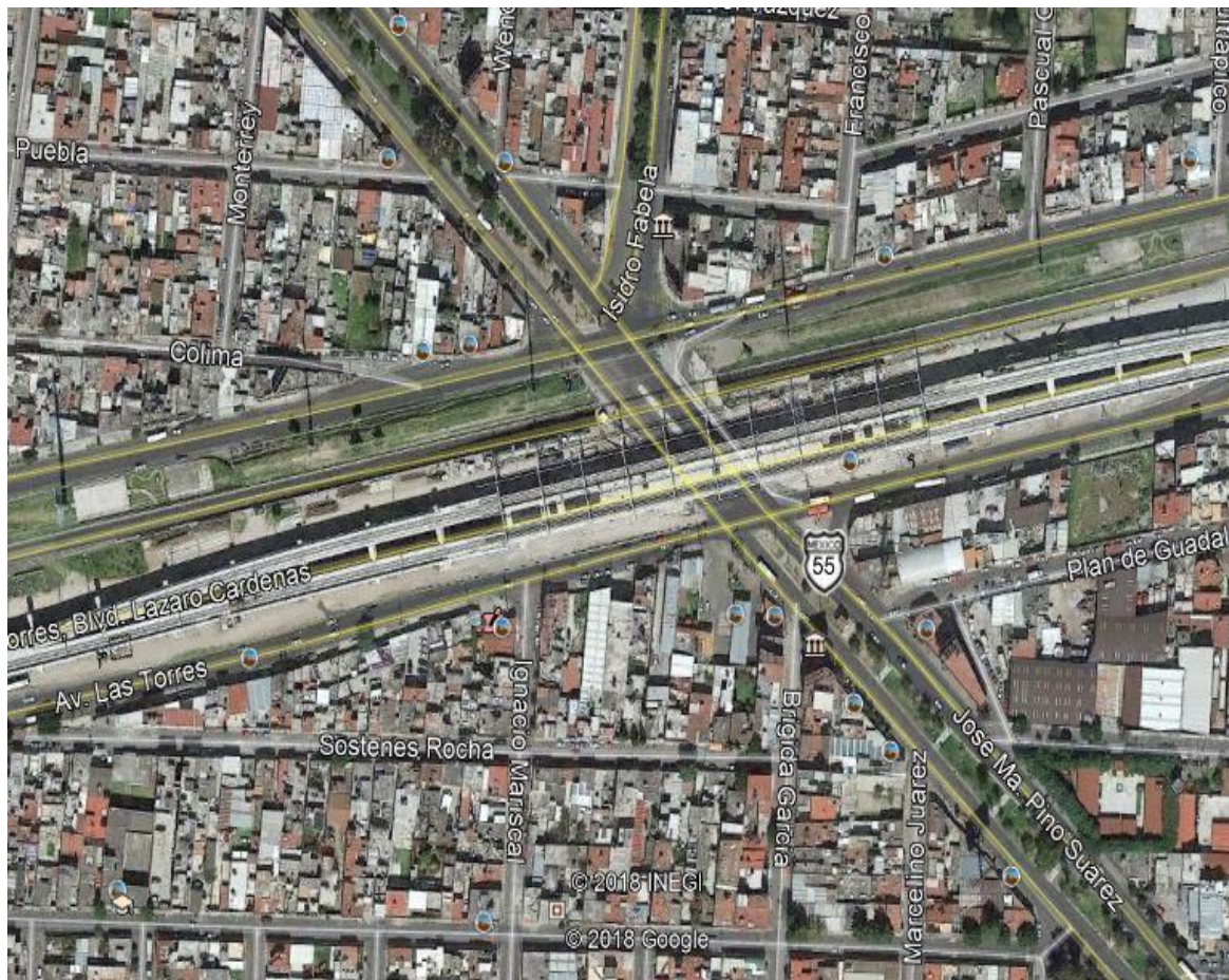
Figura 3.14. Aerofoto de estación Terminal (Pino Suárez).
