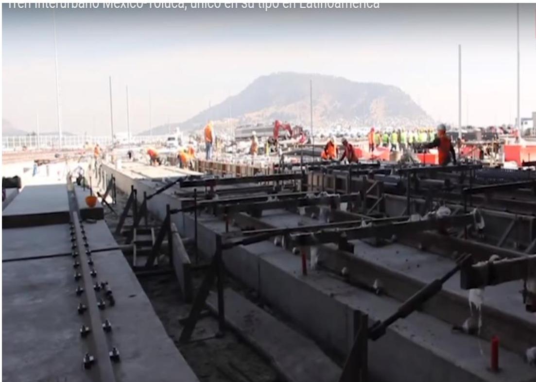
Figura 3.12. Colado de carriles en estación Buenavista. Fuente: Notimex, 2018.
