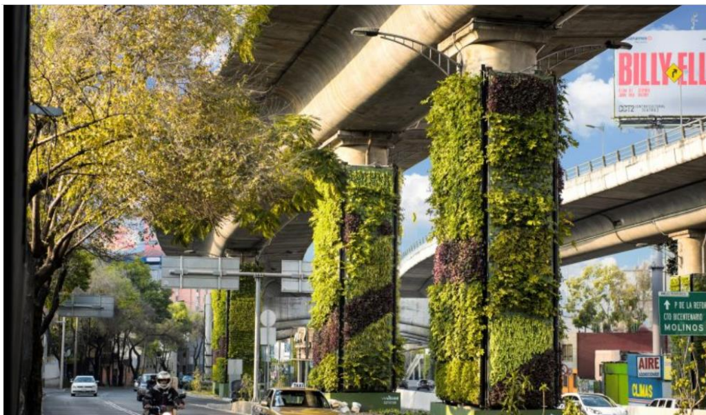
Figura 5.13. Imagen de columnas naturalizadas. Fuente: City, Fenómenos de las ciudades, revista de urbanismo, 9 de febrero 2017.
